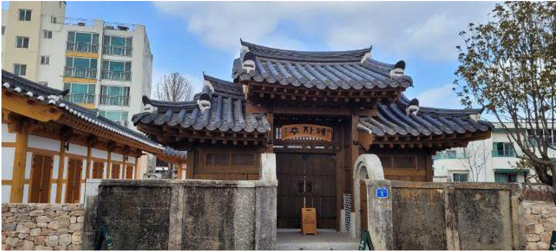
옛 담양의원 안채의 솟을 대문. 편액의 '추자혜'는 백제시대 담양의 지명.[사진=이광표]
