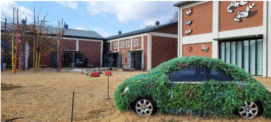
1968년 지은 양곡수매 창고를 담빛예술창고로 리모델링했다. [사진=이광표]
